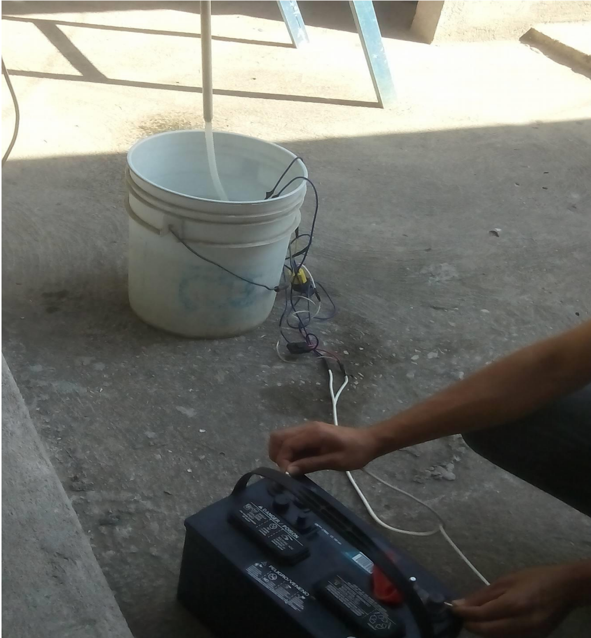
Ilustración 47 instalación de Bomba
